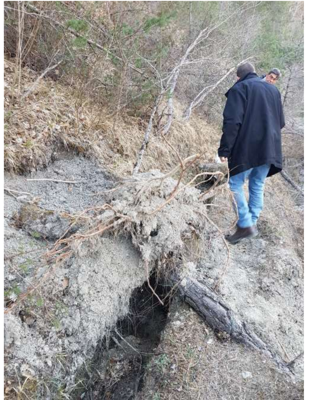
Glissement de terrain sur canal des Granges
